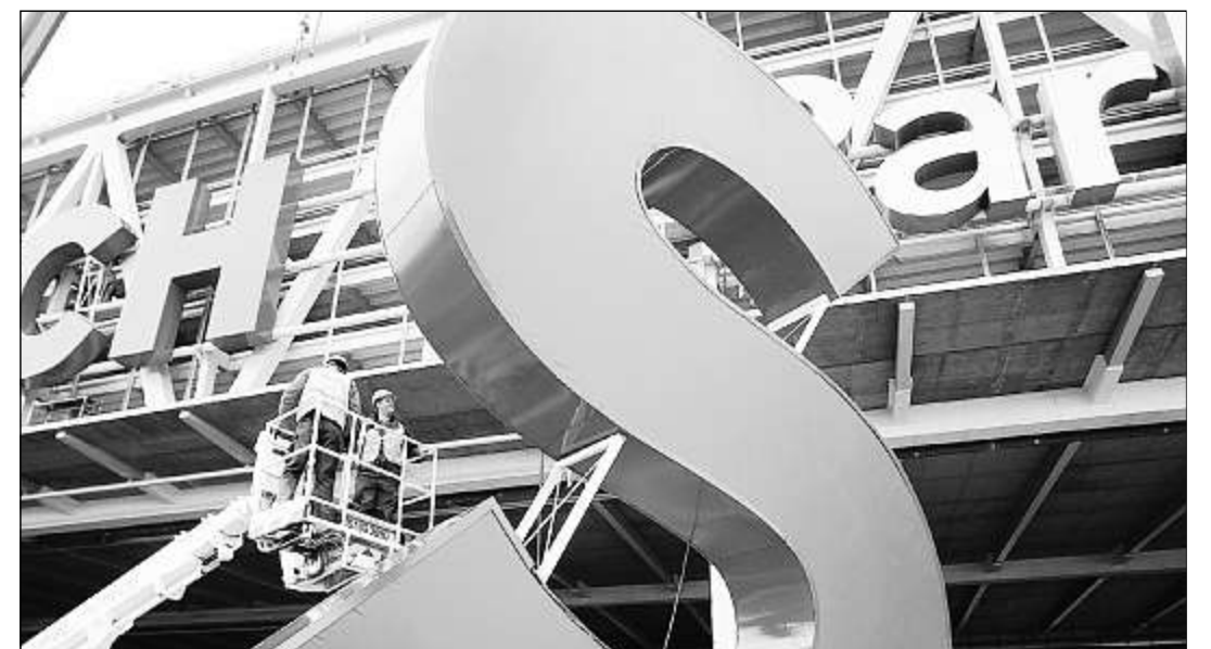
PREMIERE: Montage der LED-Leuchtreklame am Stuttgarter Messeparkhaus.
